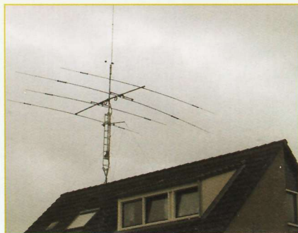
Hier zullen de verticale antenne en de beam elkaar nauwelijks beïnvloeden.
